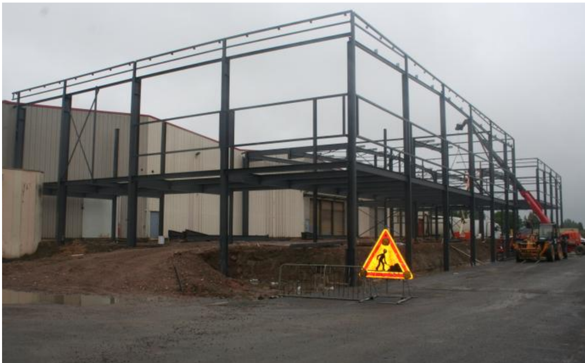
Les travaux ont démarré en mai, pendant les inondations. Ils vont durer cinq ans et permettre de gagner 3 000 m 2 .
